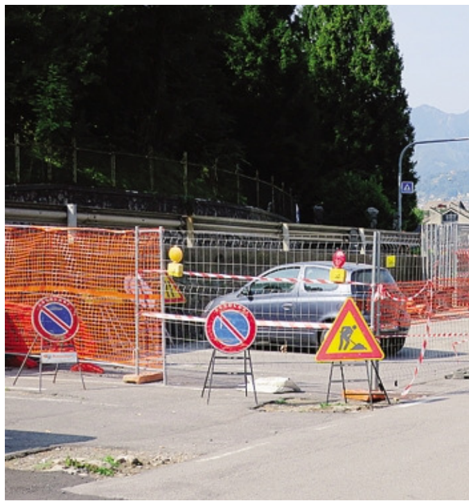
L'area del cantiere: l'intervento durerà fino a ottobre
