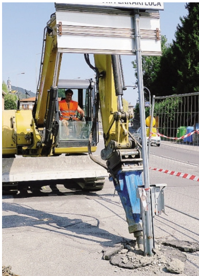
Un mezzo in azione per l'adeguamento della fognatura FOTO FRONZI
